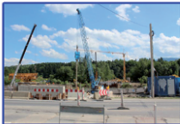
Budowa mostu w Kadczy
