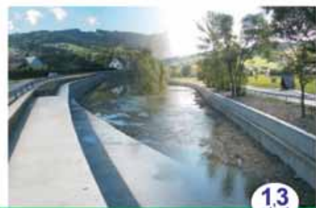
Remont zniszczonego korpusu drogowego w miejscowości Łososina Górna
