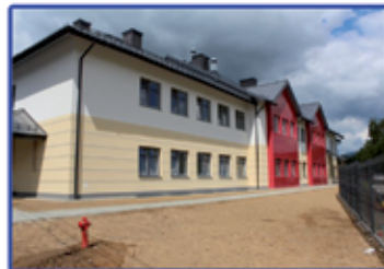
Budynek nowej szkoły w Łącko
