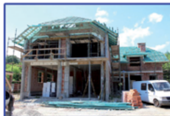
Powstający budynek wielofunkcyjny w Jazowsku
