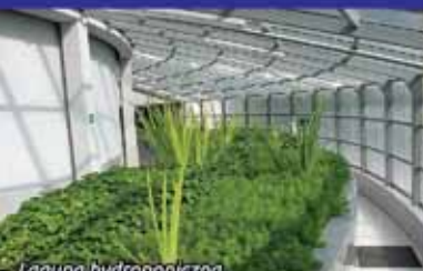
Laguna hydroponiczna na oczyszczalni ścieków
