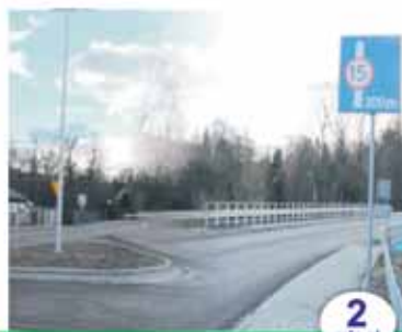
Wyremontowany most w Tymbarku wraz z dojazdami
