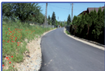
Droga po wykonaniu kanalizacji w Czerńcu
