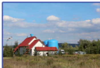
Rozbudowa oczyszczalni ścieków w Jazowsku
