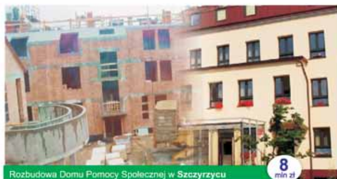
Rozbudowa Domu Pomocy Społecznej w Szczyrzycu
