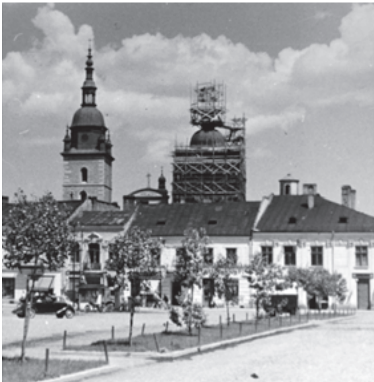
Przebudowa wieży południowej
