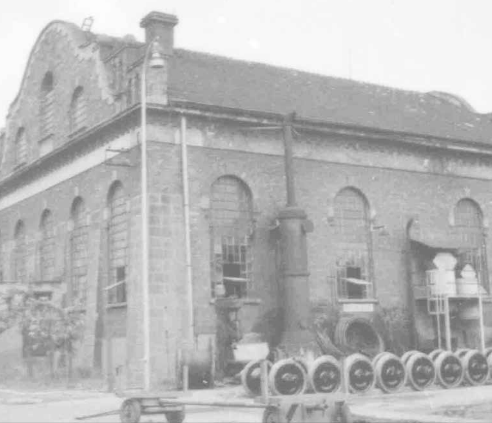
Zakład Elektryczny w Nowym Sączu
