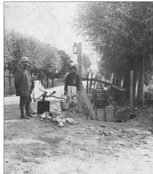
Próba rurociągu w Chełmcu
