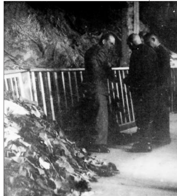
Sortowanie odzieży w Poniatowej
