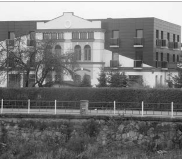
Obecny wygląd budynku po tego- rocznym remoncie
