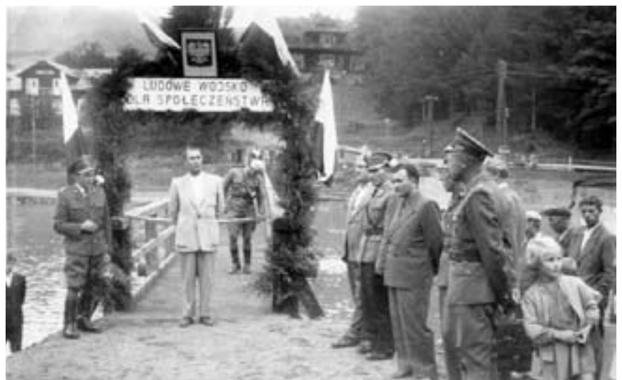
Piwniczna, oddanie kładki wybudowanej przez wojsko w miejsce mostu zniszczonego przez powódź.
