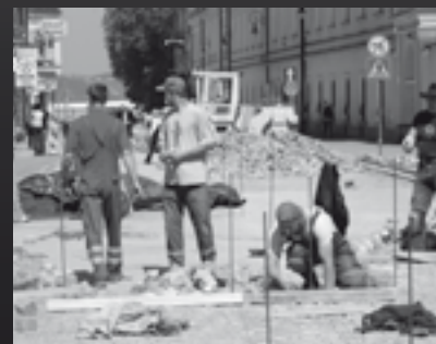
Remont ul. P. Skargi, 2009
