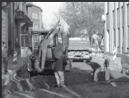
Remont ul. Szwedzkiej, 2009
