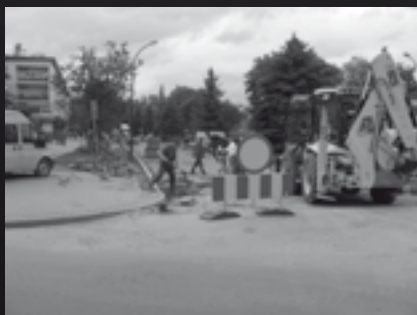
Remont al. Wolności, 2009
