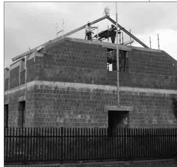
Na dudowie Sąddeckiego Hospicjum rozpoczął się montaż krokwi FOT. PG
