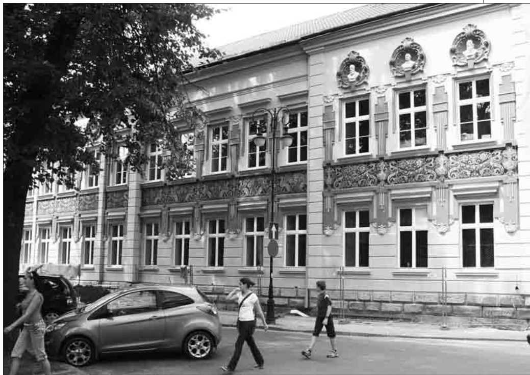
Odrestaurowana elewacja Gimnazjum nr 11 w Nowym Sączu FOT. PG
