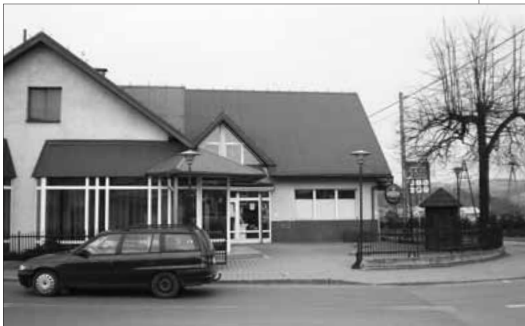
Restauracja Beskid w Gołkowicach FOT. ZYŁY
