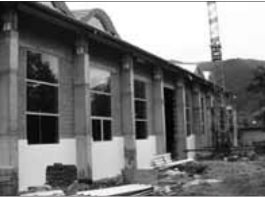
Budowa hali w Rytrze
